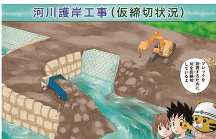
ブロックを設置するために川を仮締切しているよ
