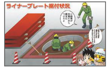
E-3 安全に作業を進めるためにライナープレートを取り付けているんだ
