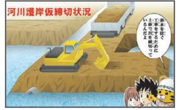
C-4 洪水を防ぐ工事をするために土砂で川を締切っているんだよ
