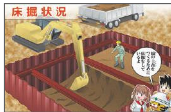
B-6 端の土台をつくるために床掘をしているよ
