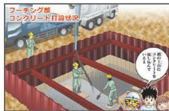
B-7 橋の土台にコンクリートを流し込んでいるよ
