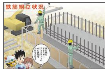
B-8 強い橋にするためにコンクリートの中に鉄筋を入れるんだよ
