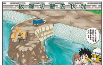
C-18 ブロックの配置が終わったので仮締切を撤去しているよ
