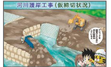
C-16 ブロックを設置するために川を仮締切しているよ
