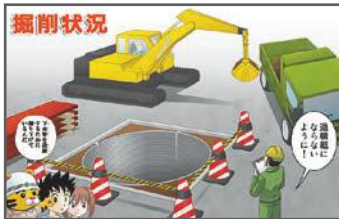
E-4 下水管を設置するために掘り下げているんだ
