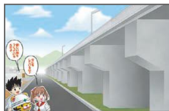
B-3 なにをしているの? / 新しい橋をつくっているんだよ
