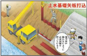
C-5 地下水が枯れないように止水矢板を打っているよ
