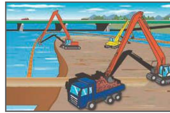
C-31 治水工事 (河道掘削)
