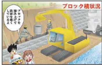
C-6 ブロックを積み上げて法面を強くしているよ
