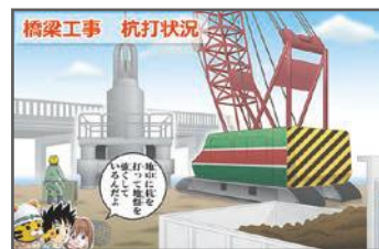
B-4 地中に杭を打って地盤を強くしているんだよ
