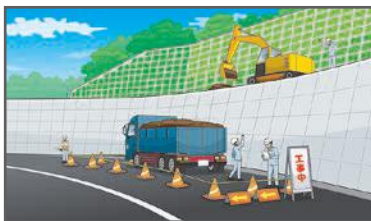
F-1 法面工事
