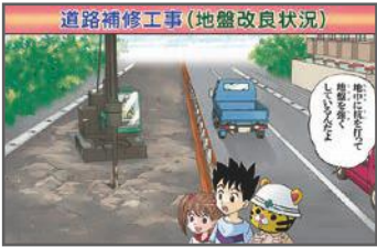
A-5 地中に杭を打って地盤を強くしているんだよ
