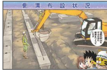
A-6 道路の排水をするために側溝をつくっているよ
