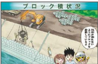
C-17 川岸が削れないようにブロックを設置しているよ
