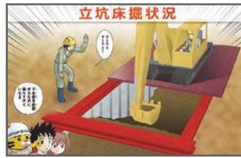
E-2 下水管を設置するために掘り下げているよ
